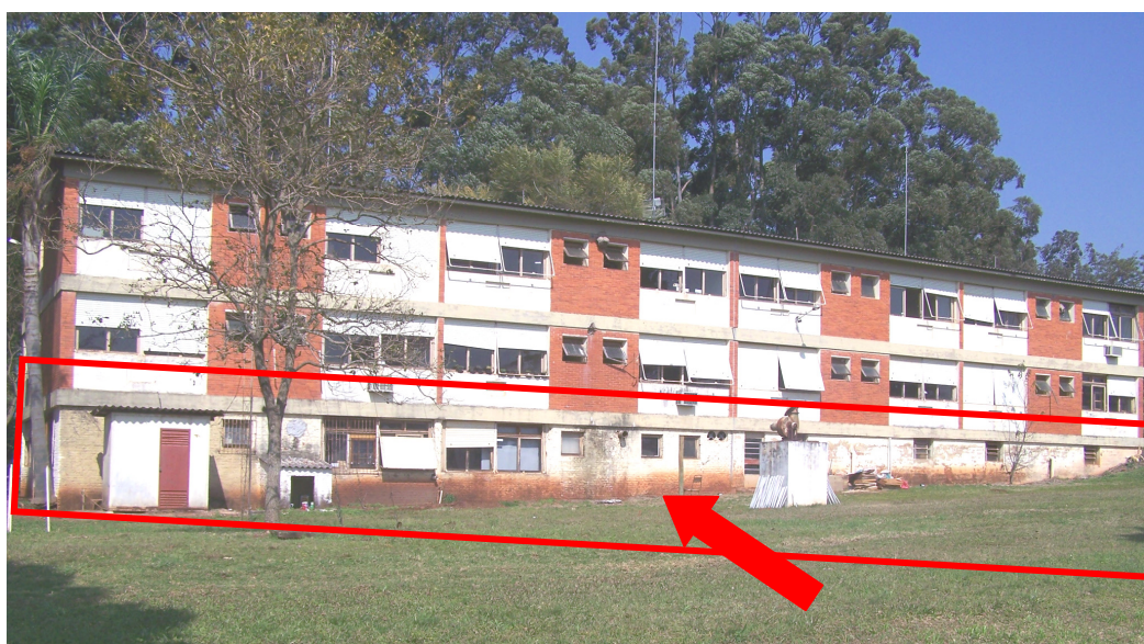
Figura 14: Antigo Laboratório de Análise de Solos da CCGL TEC, conforme indicação da seta Fonte: arquivo pessoal
